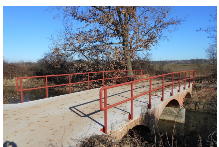
Messa in sicurezza di ponte sul rio Caramagnotta: rinforzo strutturale ed inserimento barriere protettive (€ 7.635 fondi comunali)
