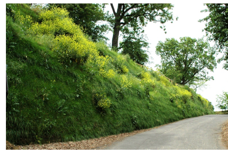
Inerbimento scarpata ripristinata in via Colle Oliva
