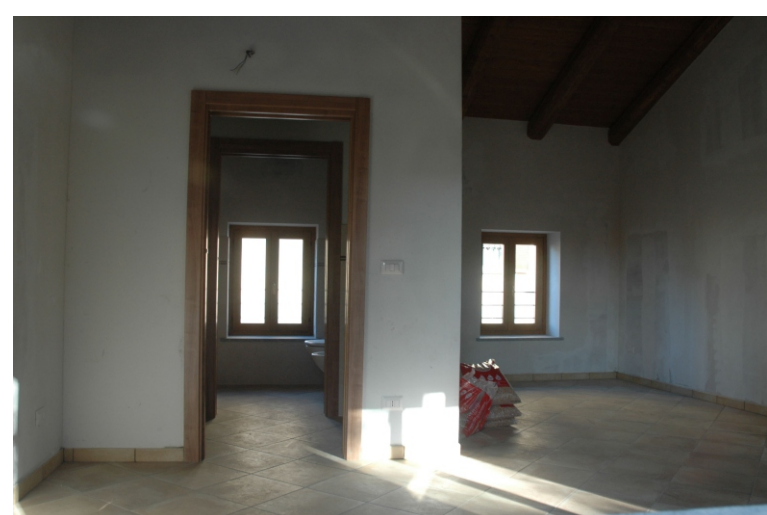
Ristrutturazione fabbricato comunale con realizzazione di monolocale per emergenza abitativa (€ 65.000 contributo Cassa di Risparmio di Cuneo + € 30.000 fondi comunali)
