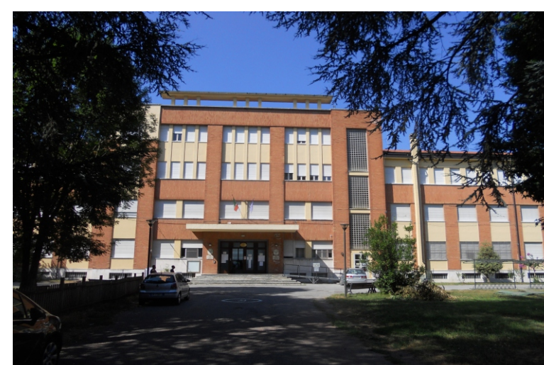
Posa pannelli su solaio della scuola per eliminare rischio caduta intonaco (€ 65.000 fondi comunali)
