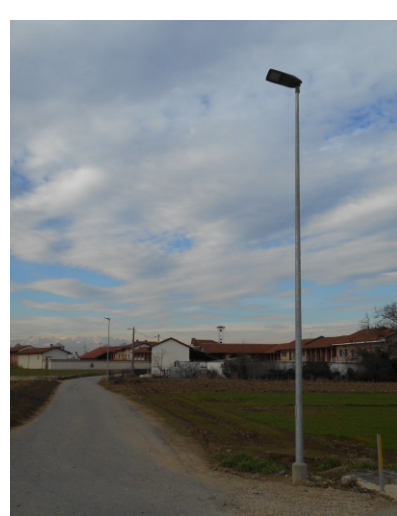
Incremento illuminazione Frazione Tavelle: sostituzione lampade e posa nuovo palo
