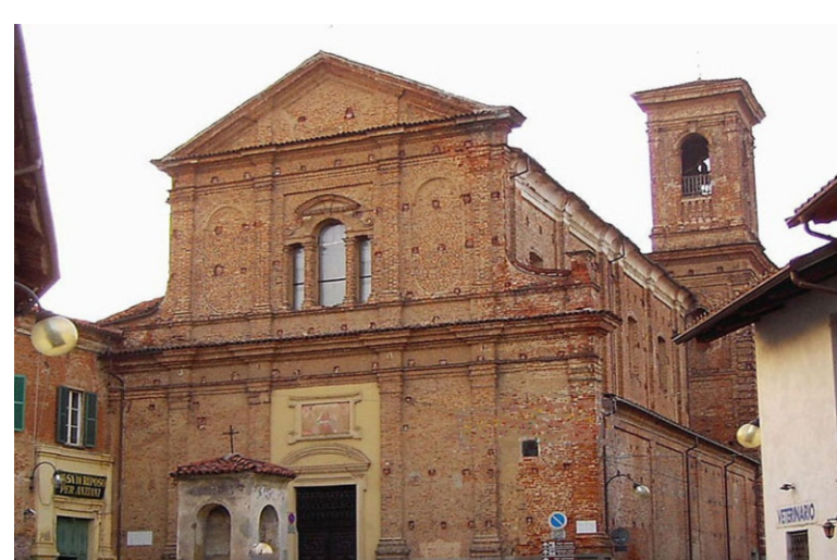
Appalto completamento sostituzione copertura chiesa del Convento, area navata unica (€ 80.000 contributo Fondazione San Paolo + € 20.000 e fondi comunali)
