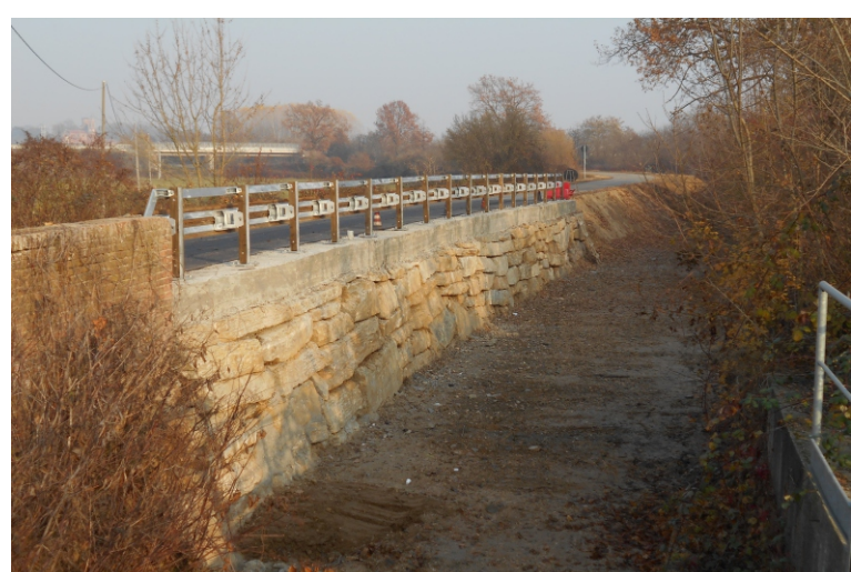
Sistemazione rio Pocapaglia con rifacimento scarpata su strada Agostinassi (€ 45.000 contributo regionale € 17.000 e fondi comunali)
