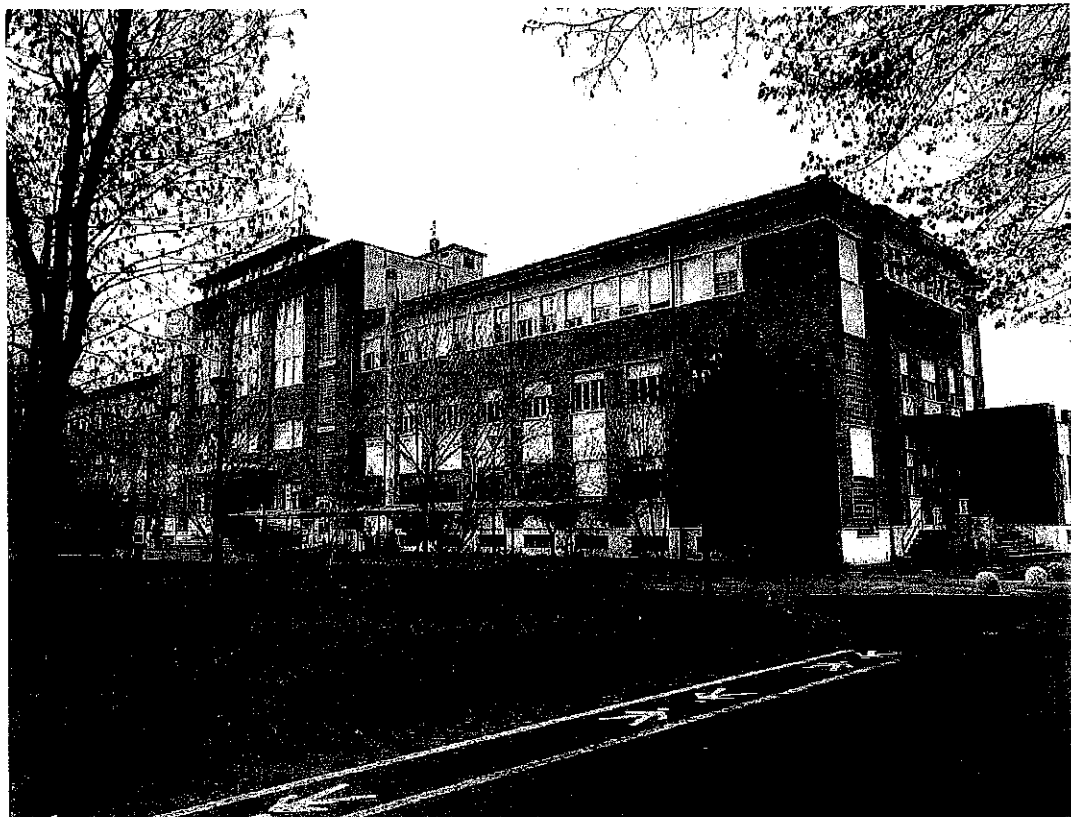
Fronte principale del fabbricato scolastico verso via Giansana
