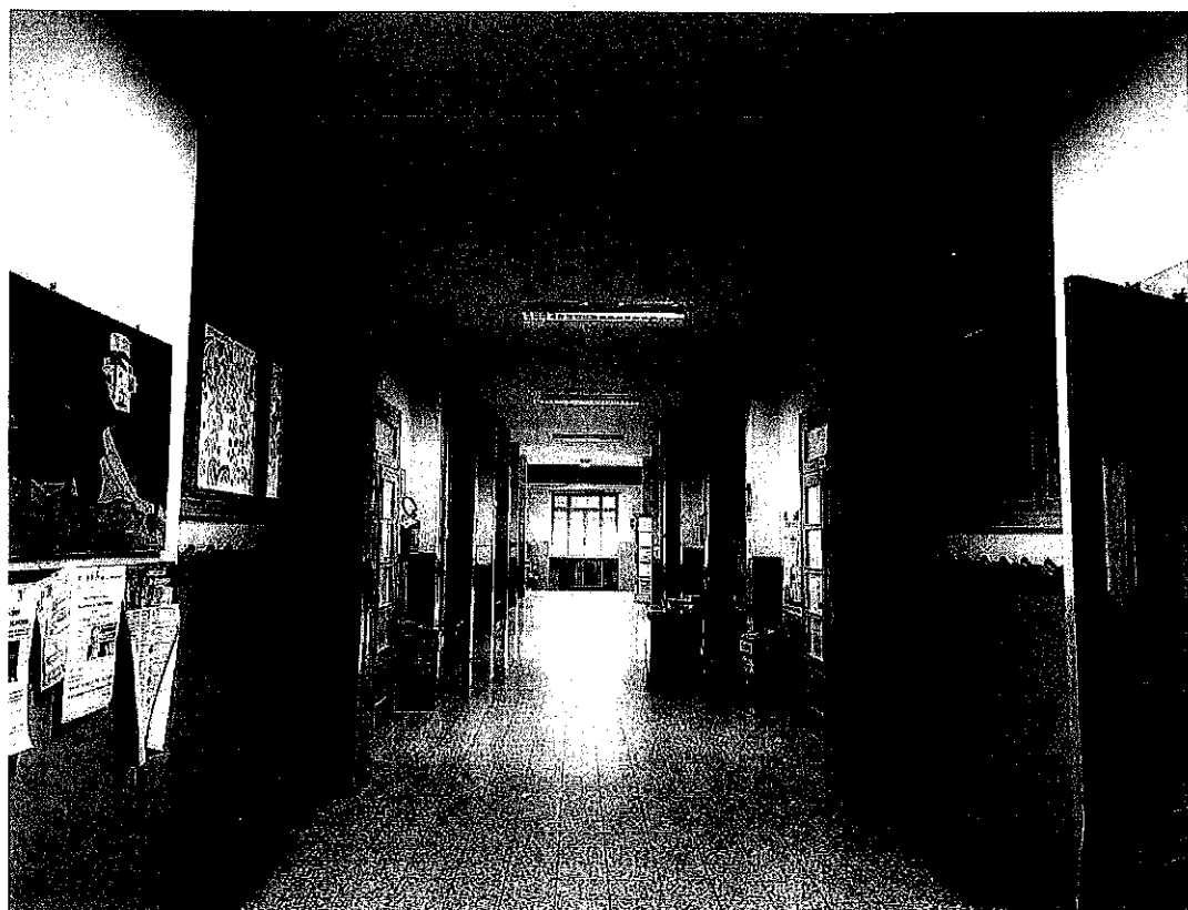
Scuola media - piano primo - Corridoio
